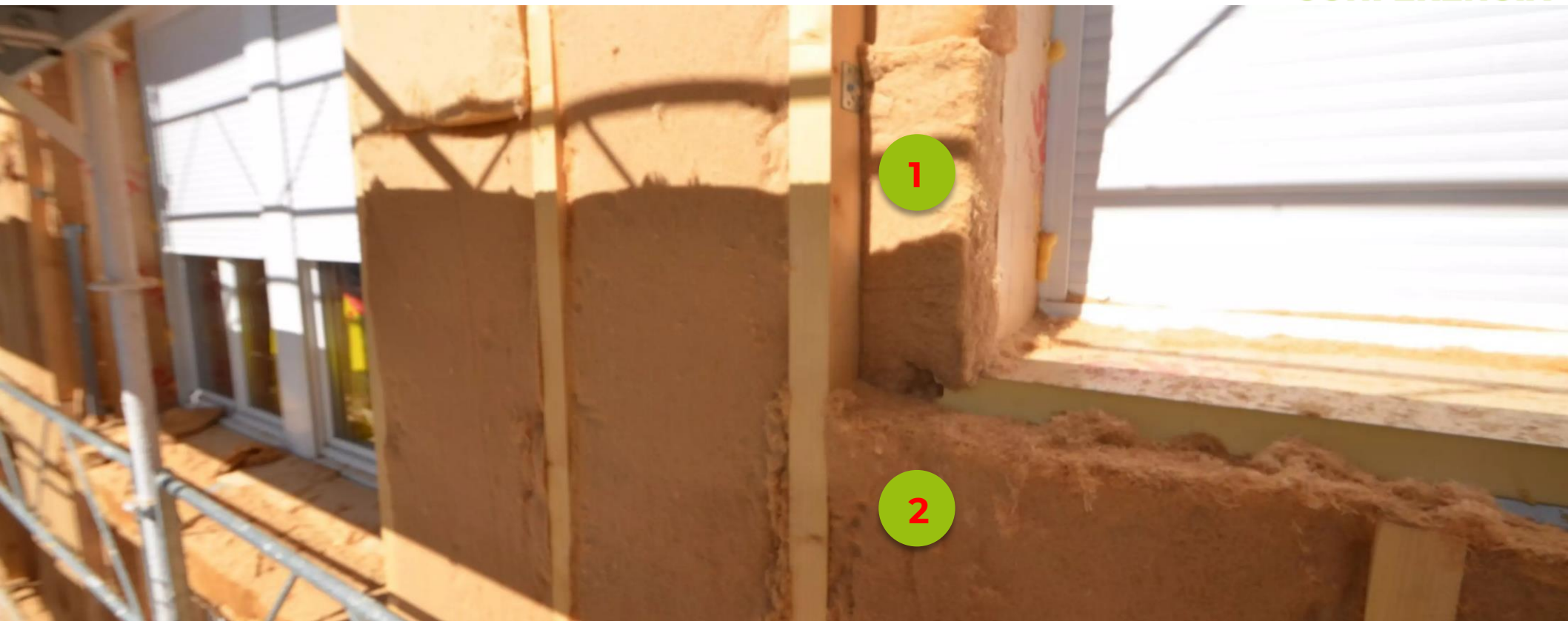
PREENCHIMENTO PAVATEX® CONFORT MEDIANTE 2 CAMADAS DE 100MM
