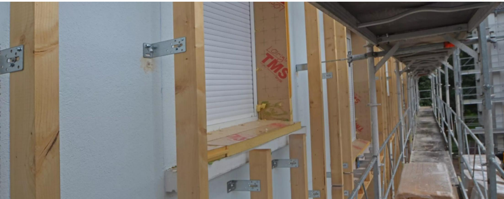
ESTRUTURA PARA RECEBER O ISOLAMENTO TÉRMICO PELO EXTERIOR
