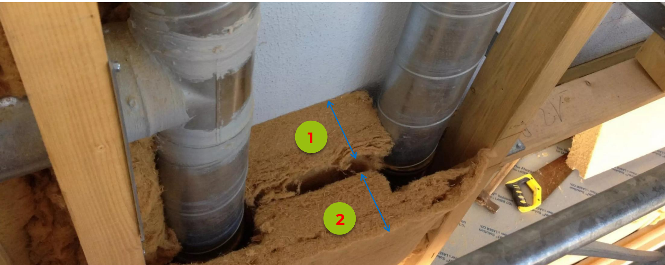
PREENCHIMENTO PAVATEX® CONFORT MEDIANTE 2 CAMADAS DE 100MM
