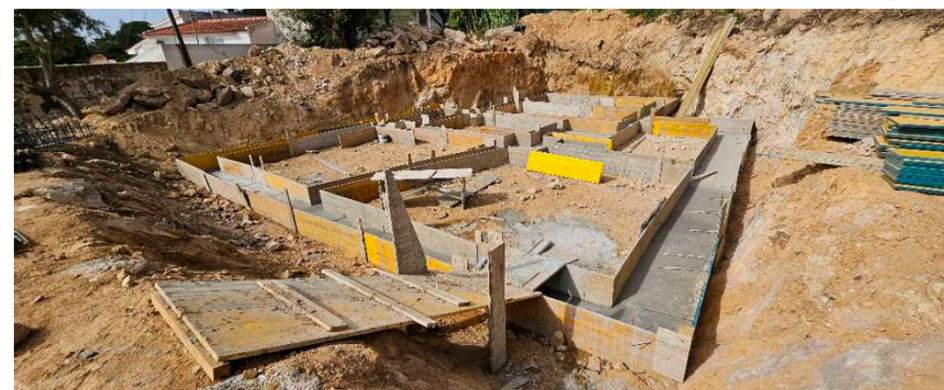
Vista geral da cofragem das fundações já com o betão de limpeza aplicado
