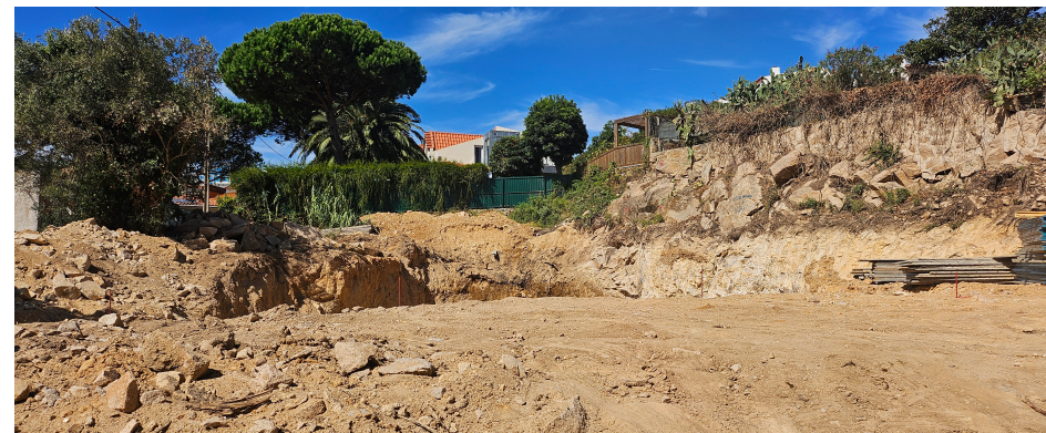
Vista da terreno após limpeza de terras e pedras, resultantes da escavação
