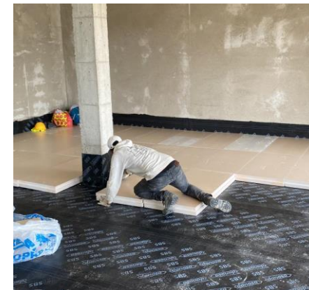
3. Impermeabilização e Isolamento XPS
