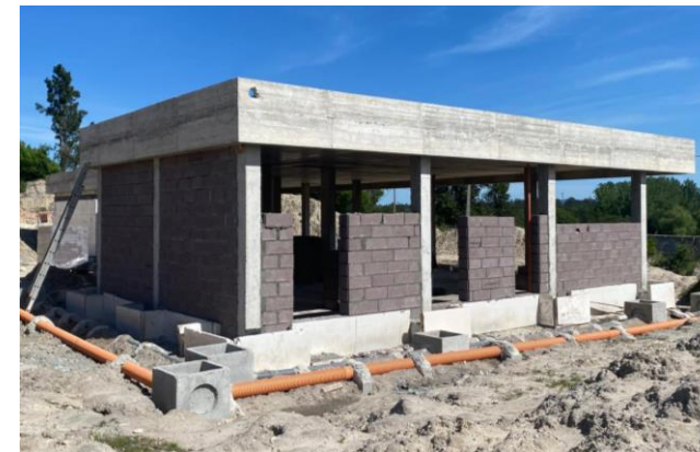
2. Parede em alvenaria de bloco térmico
