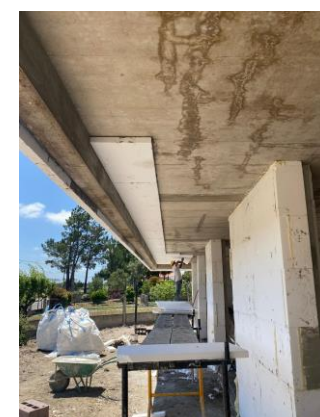
7. Isolamento parte inferior
