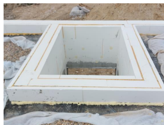
6. Revestimento de platibanda com EPS – 8 cm
