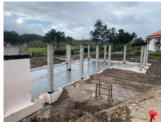
2. Betão de limpeza
