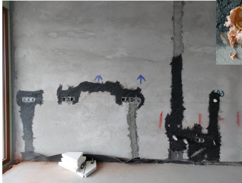
1. Aplicação em aberturas para eletricidade / águas / esgotos
