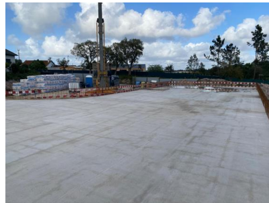
2. Laje de cobertura
