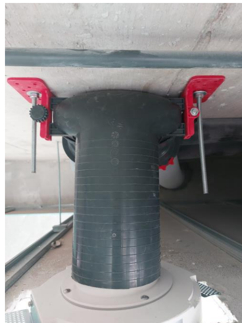
3. Vista interior teto falso
