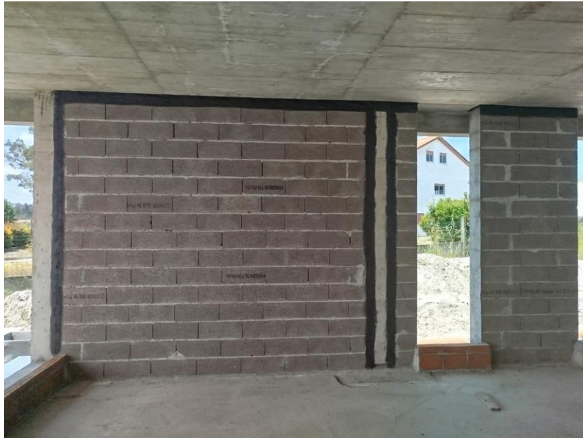
1. Aplicação em juntas
